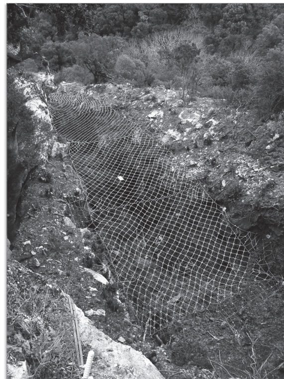
▲ Figure 11 : Mine de Las Coupes. Tranchée du Grand Barrenc, avec filet de protection installé lors de la mise en sécurité du site au début des années 2000 (photo J. Mantenant).
