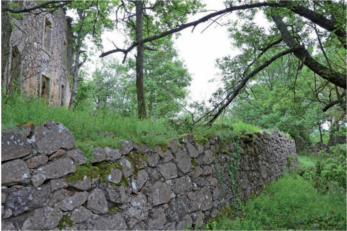
Photo 55. Mur de soutènement de la terrasse supérieure
