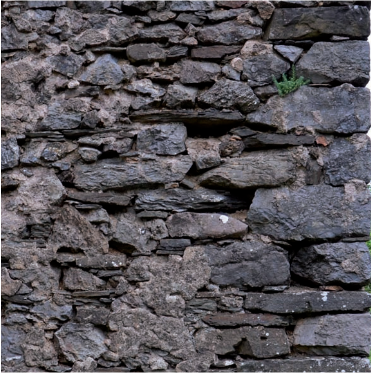
Photo 37. Restes d'enduits sur la façade ouest du corps principal
