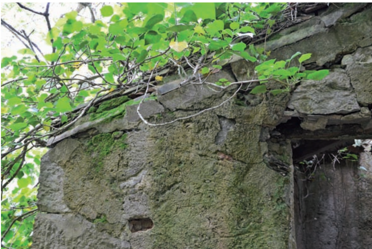
Photo 54. Couverture des latrines
