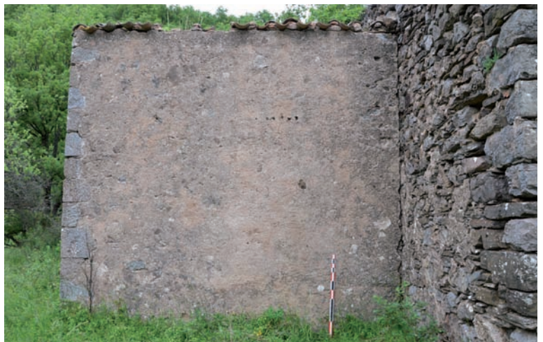
Photo 41. Façade sud de l'extension
