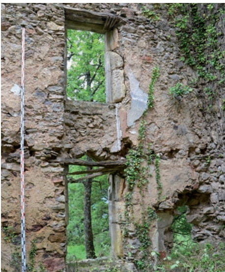
Photo 16. Linteaux en bois des fenêtres
