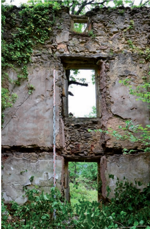
Photo 10. Fenêtres des trois niveaux
