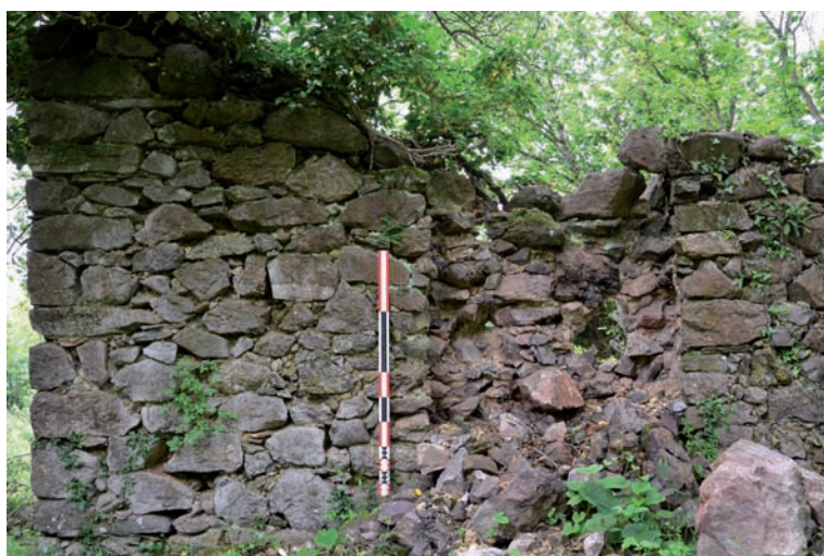
Photo 23. Porte murée sur la façade nord
