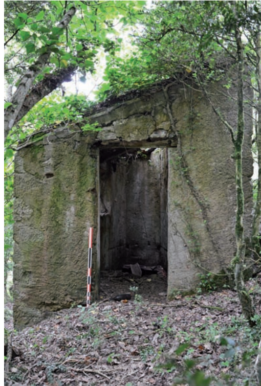
Photo 47. Porte d'entrée des latrines
