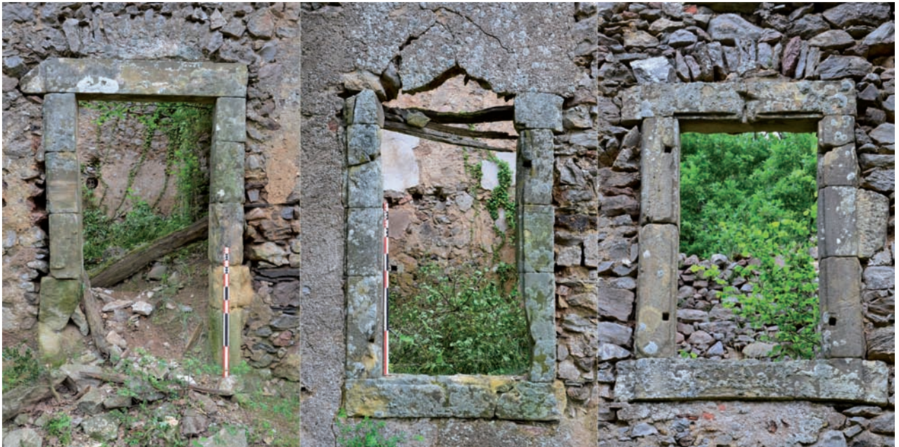
Photo 15. Encadrement de la porte et des fenêtres du rez-de-chaussée et du premier étage
