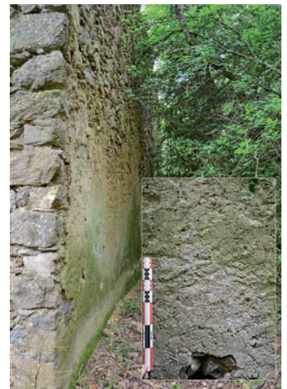
Photo 18. Enduit de la façade nord
