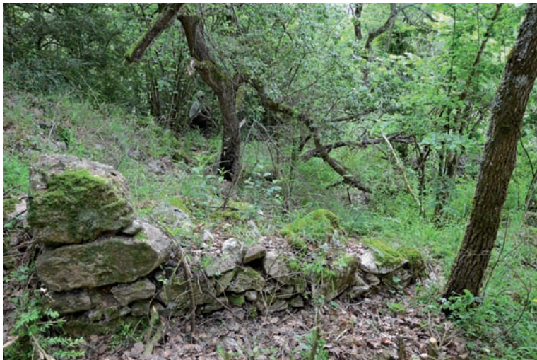
Photo 43. Restes du mur ouest de l'ancienne bergerie
