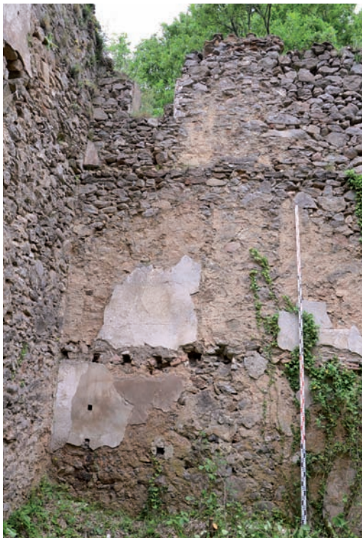
Photo 4. Mur nord vu depuis l'intérieur du bâtiment
