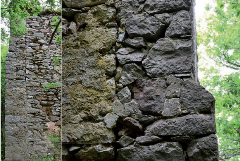
Photo 13. Contrefort du mur ouest
