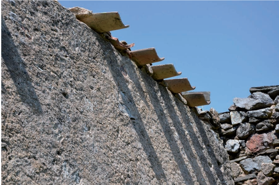
Photo 42. Tuiles canal en bordure du toit de l'extension
