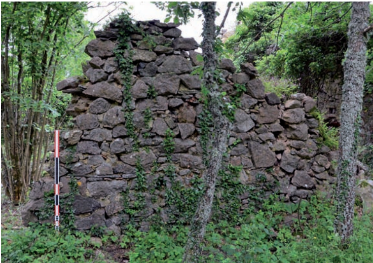
Photo 35. Parement et chaînage du corps principal, façade nord
