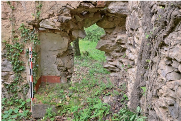
Photo 6. Evier du rez-de-chaussée
