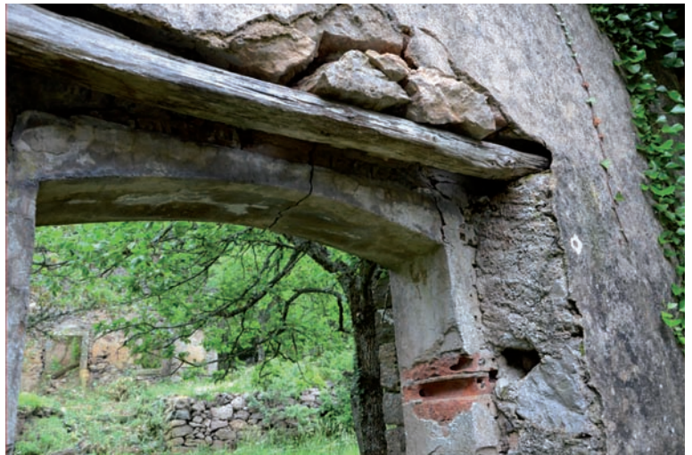
Photo 40. Linteau de la porte de l'extension
