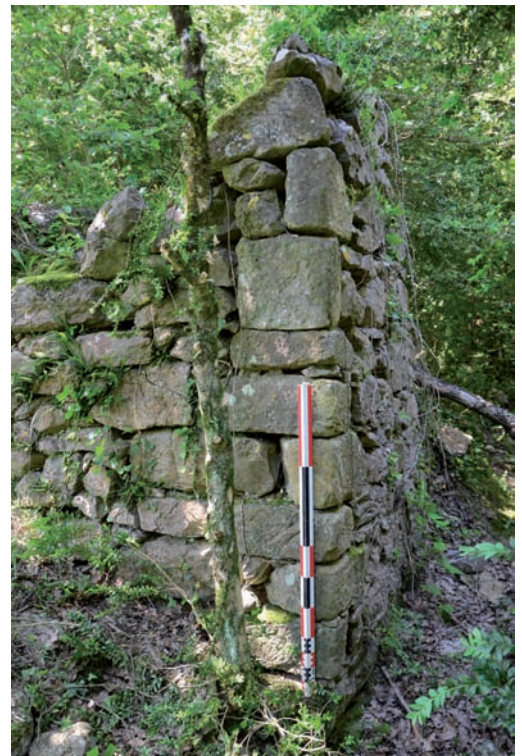
Photo 45. Chaînages d'angle de l'ancienne bergerie
