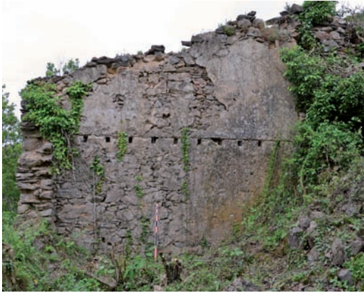
Photo 25. Façade ouest de la pièce sud vue depuis l'intérieur
