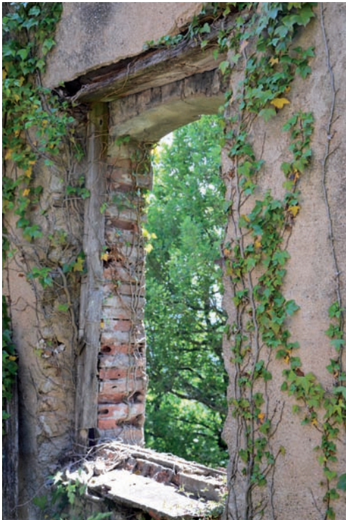
Photo 39. Fenêtre de l'extension
