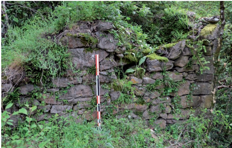
Photo 44. Façade sud de l'ancienne bergerie
