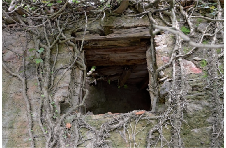
Photo 52. Fenêtre des latrines
