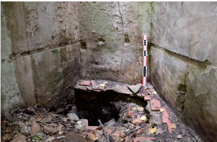
Photo 48. Emplacement du siège des latrines
