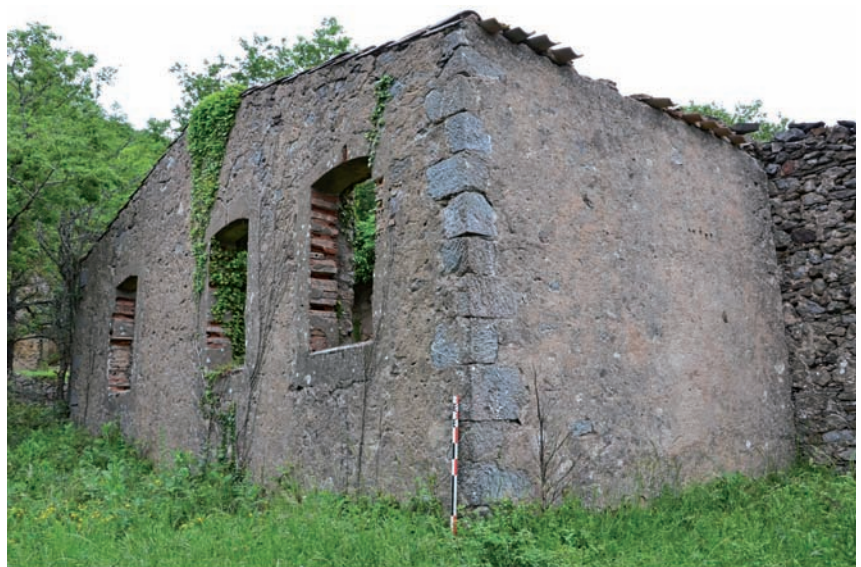
Photo 32. Façade ouest de l'extension
