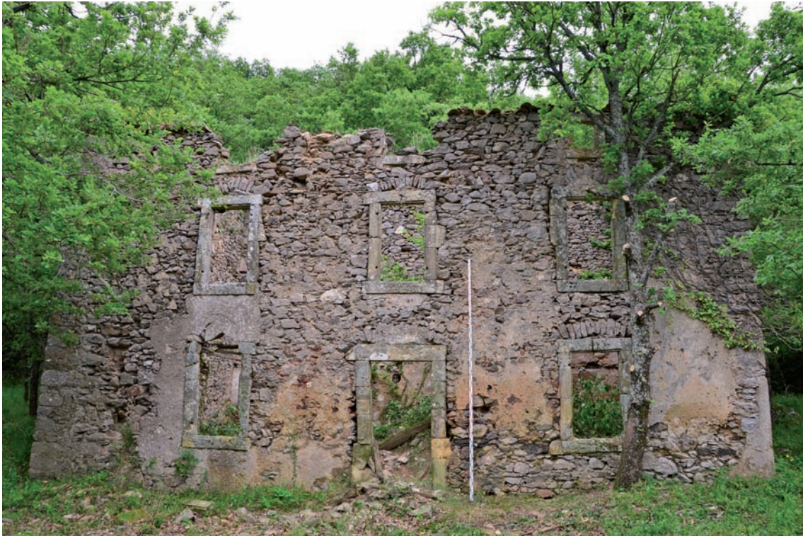
Photo 3. Façade sud de la maison d'habitation
