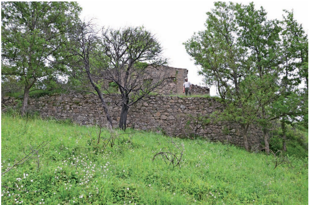
Photo 56. Mur de soutènement de la terrasse inférieure
