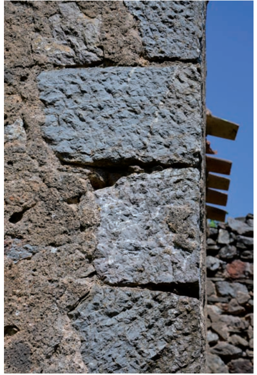
Photo 38. Chaînage d'angle de l'extension
