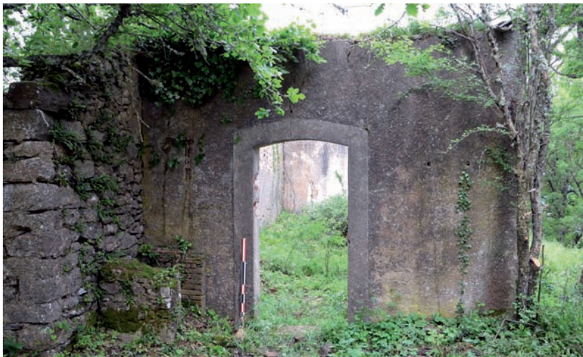
Photo 31. Entrée de l'extension
