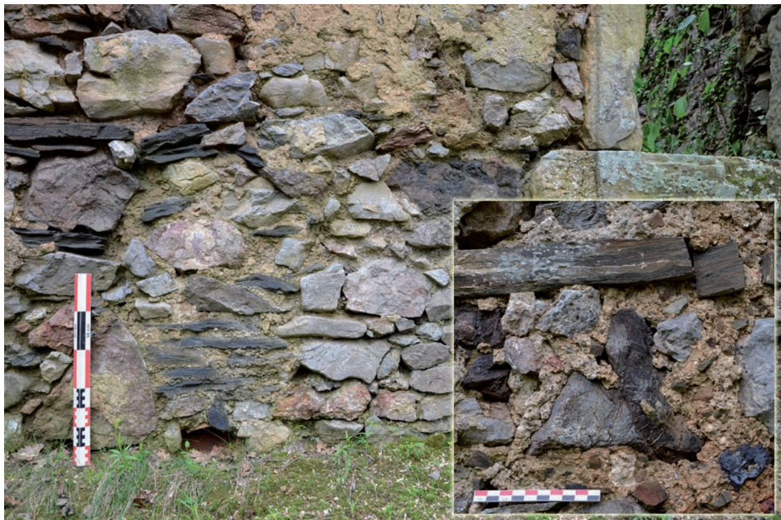
Photo 12. Différents types de blocs utilisés dans l'appareil des murs
