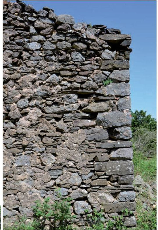
Photo 34. Parement et chaînage du corps principal, façade ouest
