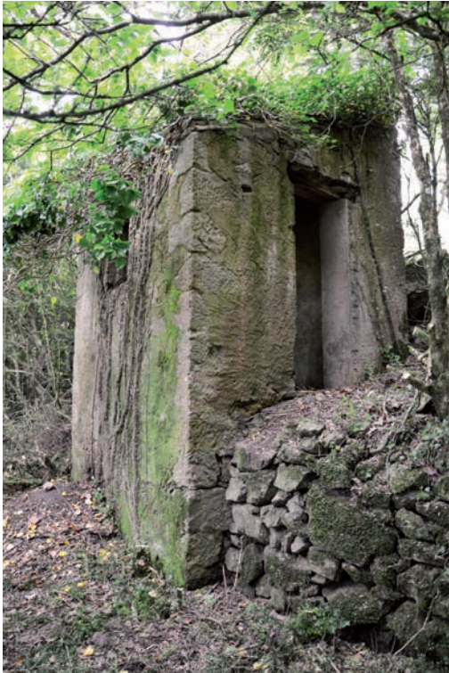
Photo 46. Les latrines vues depuis le chemin
