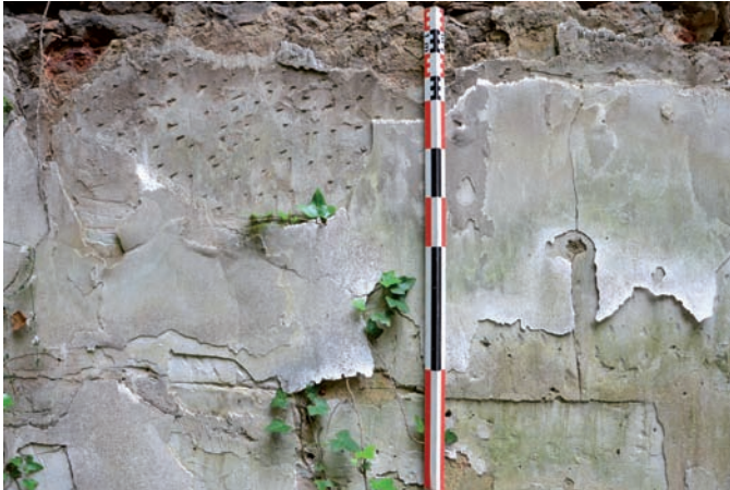
Photo 19. Les différentes couches de l'enduit et du plâtre à l'intérieur
