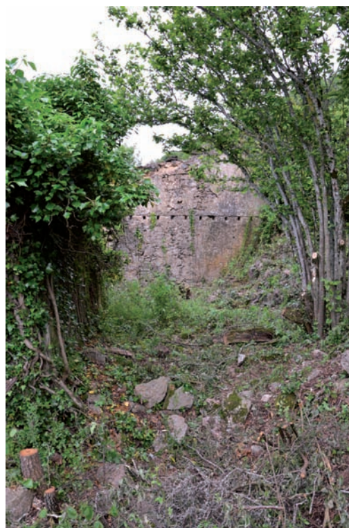
Photo 24. Intérieur de la pièce sud
