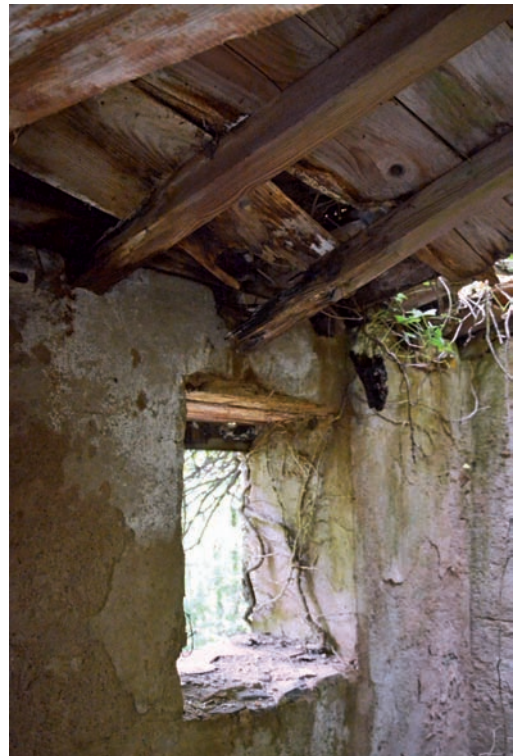
Photo 53. Charpente des latrines
