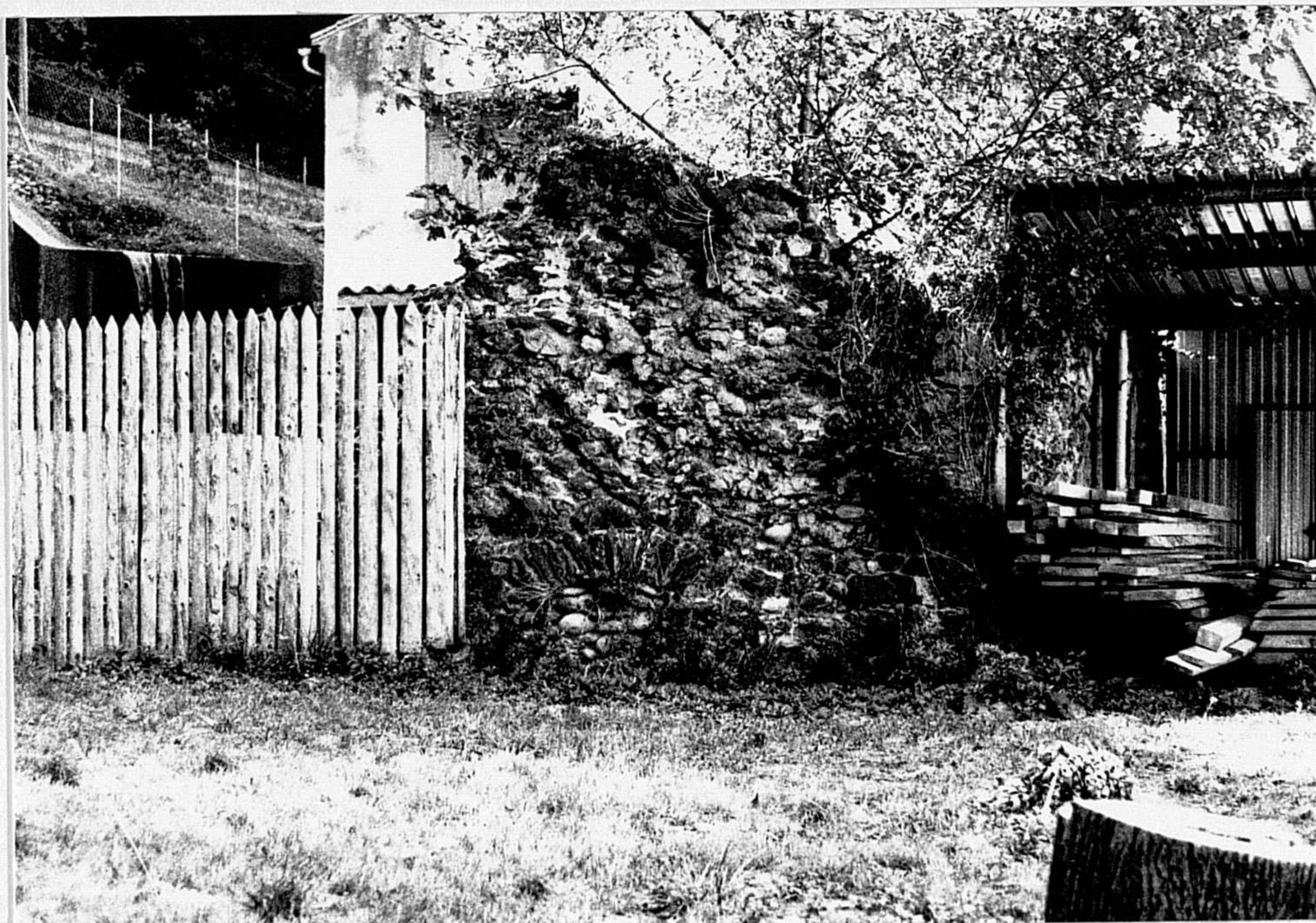
85 11 II _8 - Mur du martinet
